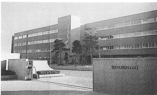
下飯田に完成した甲府二高新校舎。これがそのまま現在の甲府西高の校舎となっている。
