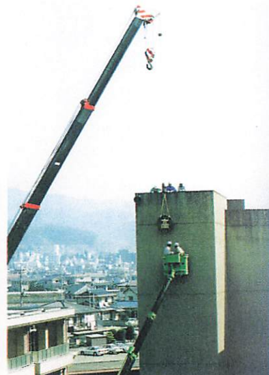
本館正面 校章の取り付け工事(平成4年3月)
